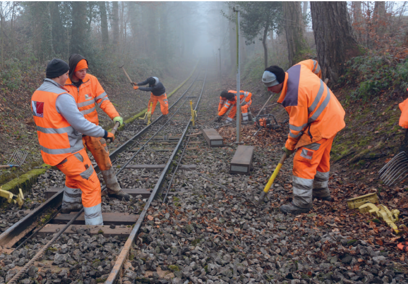
Fünf angehende Verkehrswegbauer, ein Praxisausbildner und ein Schnupperstift der Vanoli AG nutzten die trockenen Dezember-Tage um 43 der 250 Holzschwellen zu ersetzen.
